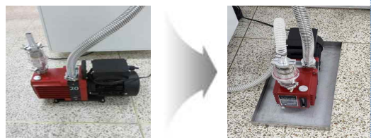
펌프 하부 받침대 설치
